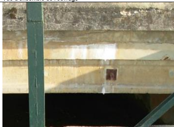
Traces de calcites en retombée de trottoir
