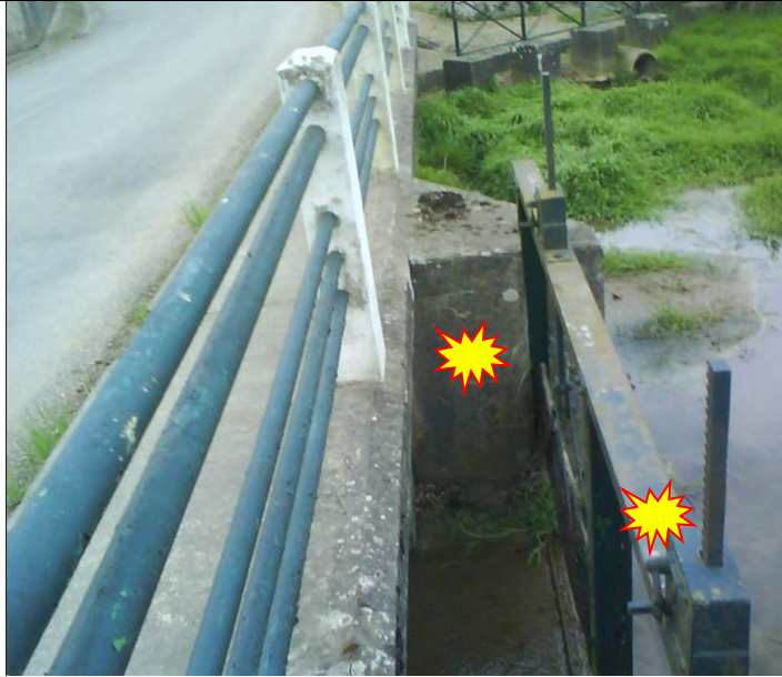
Vannage en amont et massif béton à supprimer
