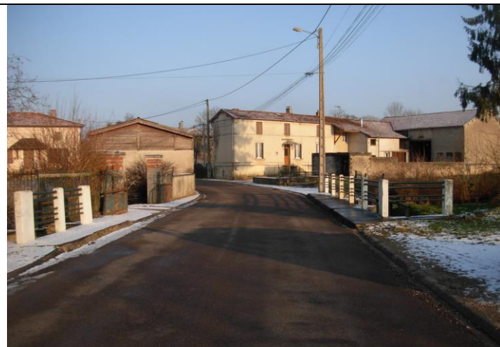
Vue d'ensemble de l'ouvrage
