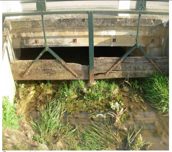
Etat actuel du vannage
